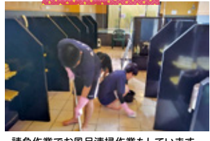
請負作業でお風呂清掃作業もしています。
